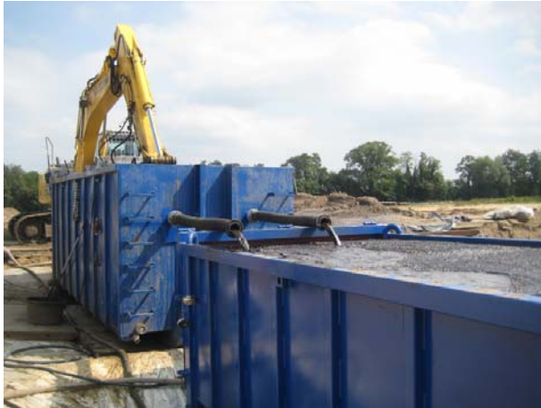
Abbildung 2: On-Site-Bodenwäsche nach dem OSBO ® -Verfahren mit nachgeschalteter multifunktionaler Trennstufe.
